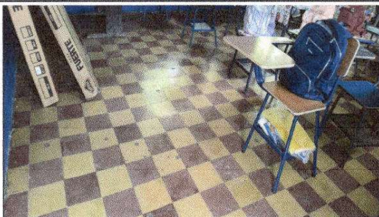
FOTO 7: Sustrucción de piso cerámico
