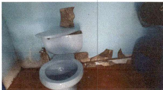
FOTO 4: Sustitución de azulejo
