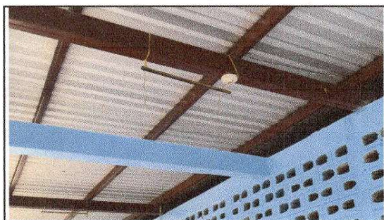
FOTO 9: Sustrucción de focos ahorradores
