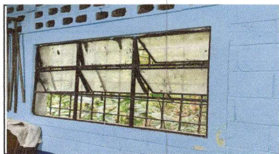
FOTO 6: Sustitución de estructura de metal de ventana
